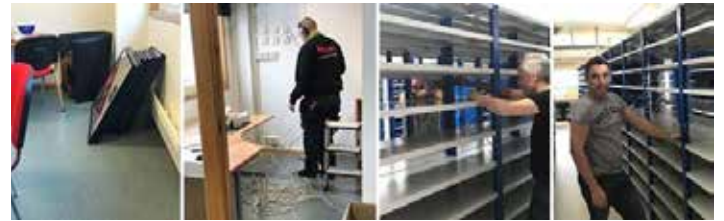
Många tavlor går det åt att smycka lokalerna på ett fint sätt. Grabbarna från MINEL är och drar el och nätverk medan Fredrik & Kerim skruvar krysssteg i plocklagret.
